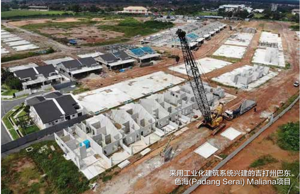
这些单层排屋的构件在工厂预制，再被运到施工现场
